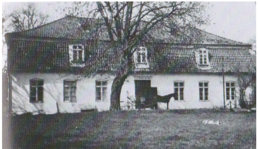
Gutshaus Gr. Klitten
